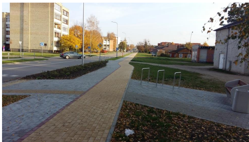
5. pav. Varėnos m. Dzūkų g. po rekonstrukcijos
