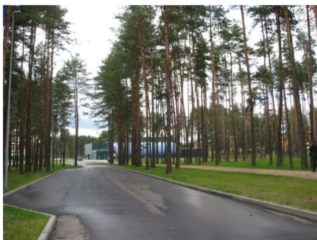
Išasfaltuotas Varėnos m. J. Basanavičiaus g. privažiavimas prie Varėnos sporto centro baseino
