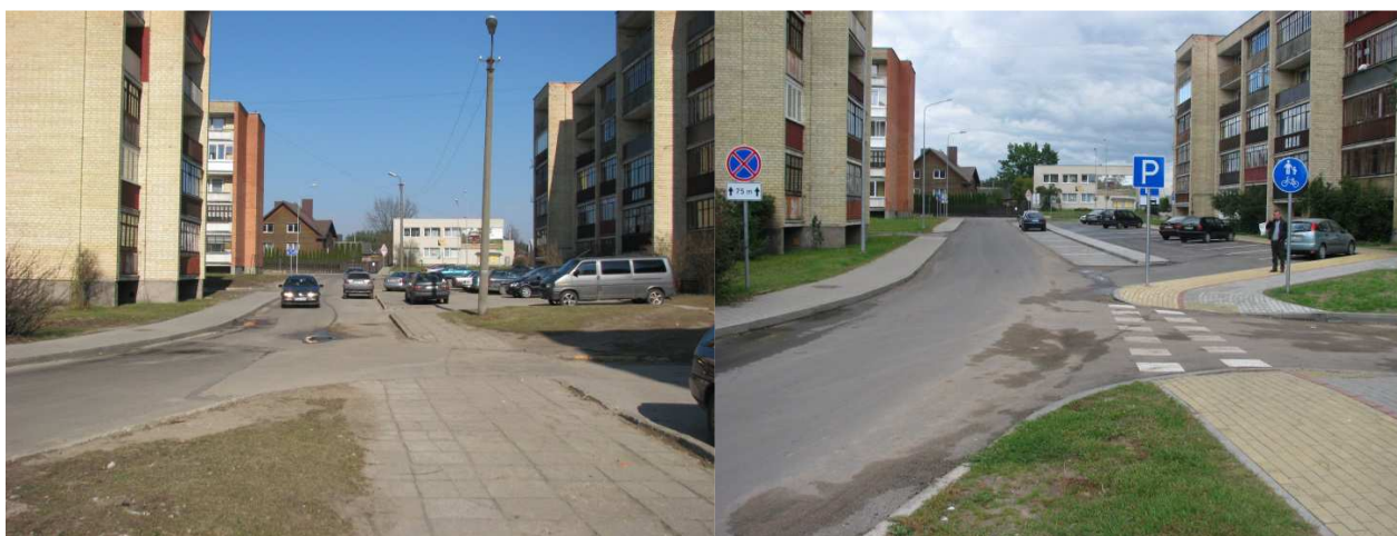
Z. Voronecko g. prieš ir po rekonstrukcijos
