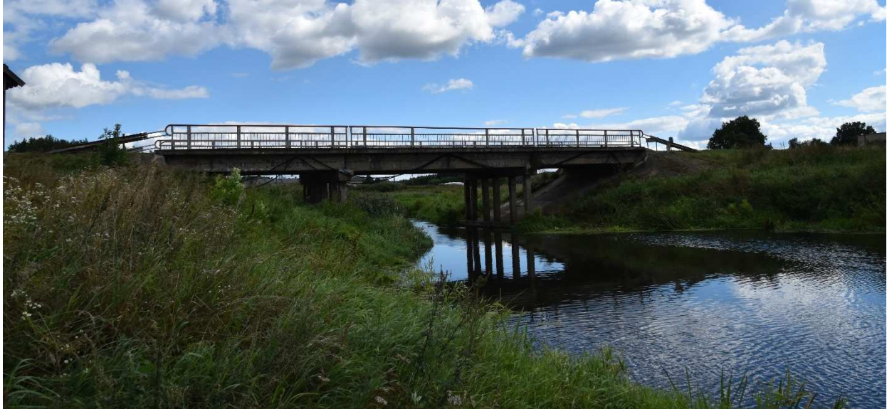
2 pav. Tiltu per Ūlos upę fasadinis vaizdas.
