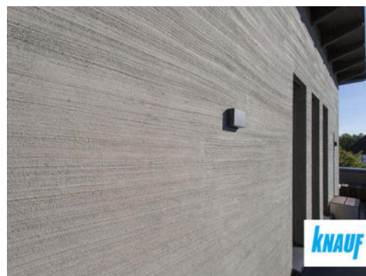
Pav. 4 Fasadų apdaila UHPC betonas arba mineralinis tinkas
