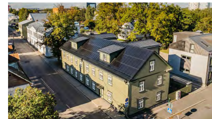
Į stogo sakrą Integruotų saulės elektrinių vaizdas istorinėje aplinkoje Talinas, Kalamaja rajonas Gaminys: https://roofit.solar/solar-roof/solar-roof-panels/
