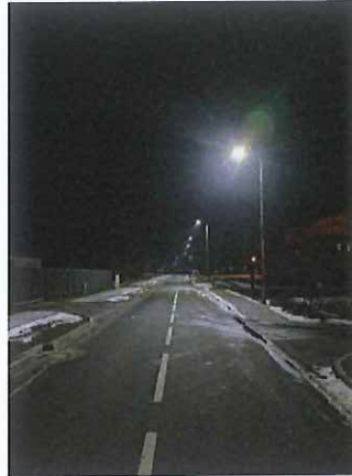
Varėnos m. Melioratorių gatvės apšvietimas.
