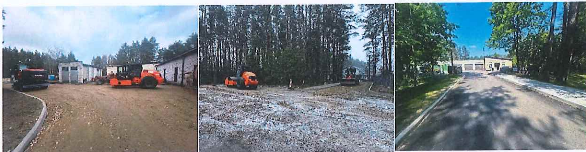
Varėnos m. Žalioji g. 26 automobilių aikštelės dangų remontas
