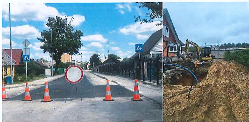
Varėnos m. Laisvės g. vandentiekio ir nuotekų tinklų statyba
