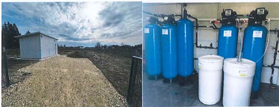
Vazgirdonių gyvenvietės vandens gerinimo įrenginių nauja statyba
