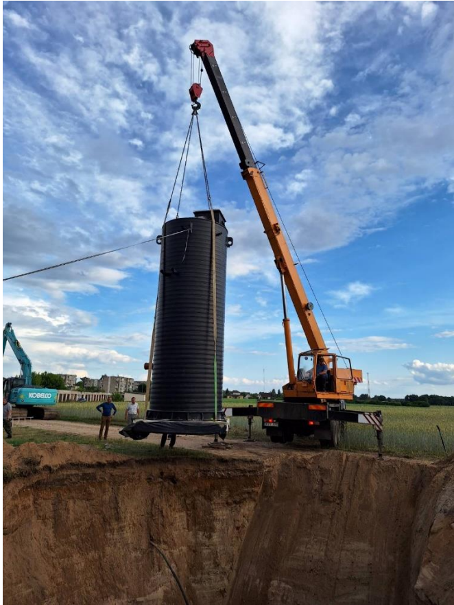
35 pav. Matuizų gyvenvietės pagrindinės buitinių nuotekų siurblinės statyba
