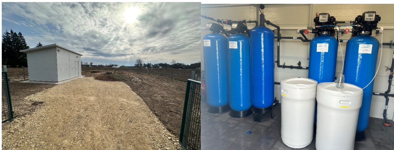
34 pav. Vazgirdonių gyvenvietės vandens gerinimo įrenginių nauja statyba
