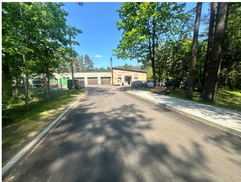
36 pav. Varėnos m. Žalioji g. 26 automobilių aikštelės dangų remontas
