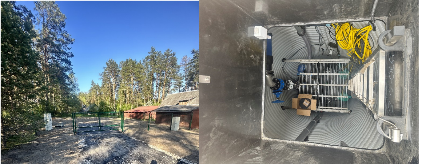
35 pav. Spenglos gyvenvietės buitinių nuotekų siurblinės statyba
