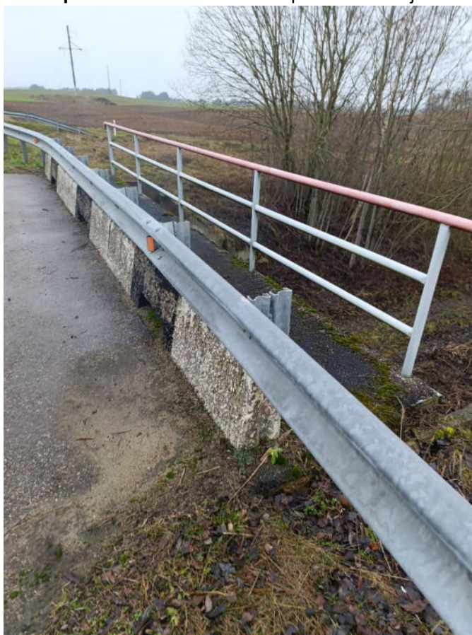
3 pav. Viaduko g/b atitvarai
