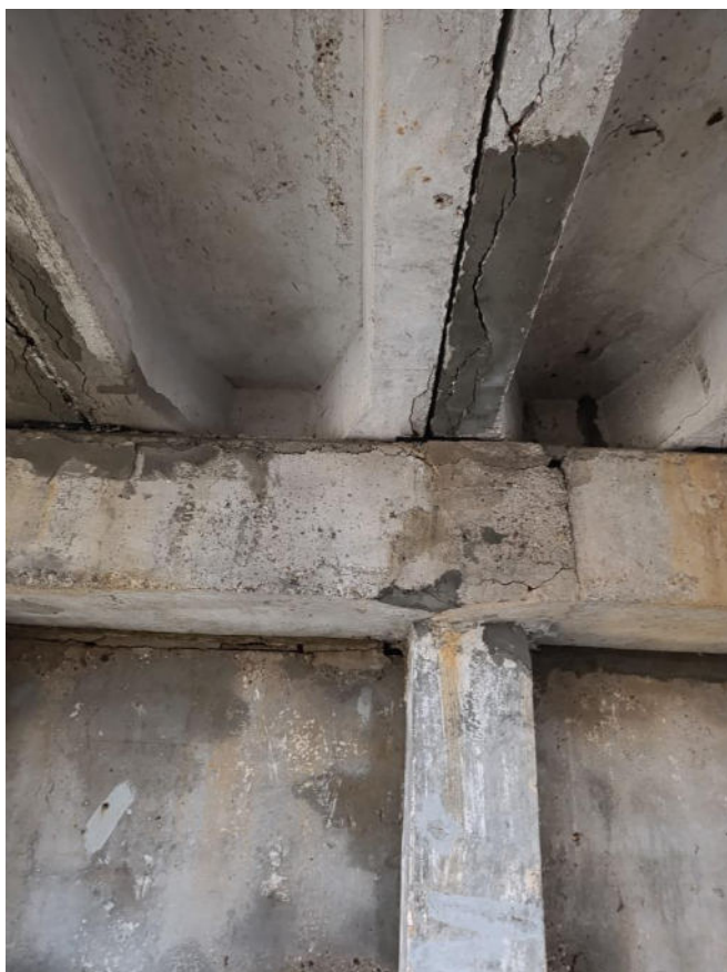
8 pav. Pažeistos viaduko krantinės atramos
