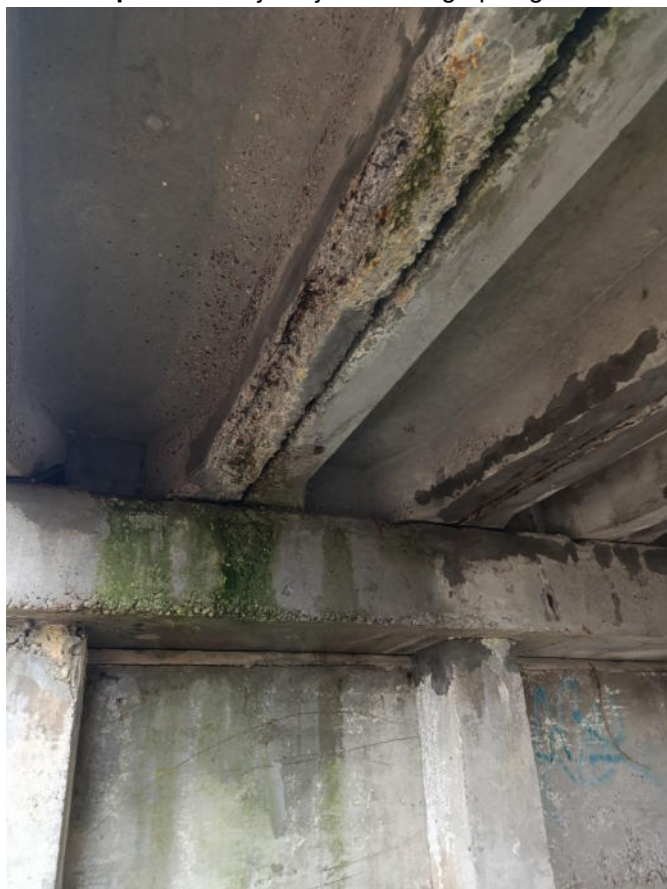
5 pav. Kiauri deformaciniai pjūviai
