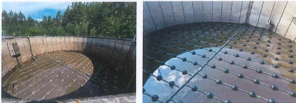
Varėnos miesto valymo įrenginiuose sutvarkyti aerotankai
