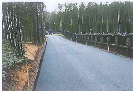
Išasfaltuotas kelio Nr. Var113v privažiavimas prie Varėnos m. kapinių ruožas
