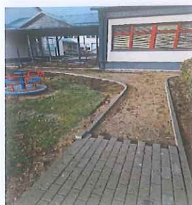
Varėnos „Pasakos“ vaikų lopšelio-darželio teritorijos susisiekimo infrastruktūros atnaujinimo darbai
