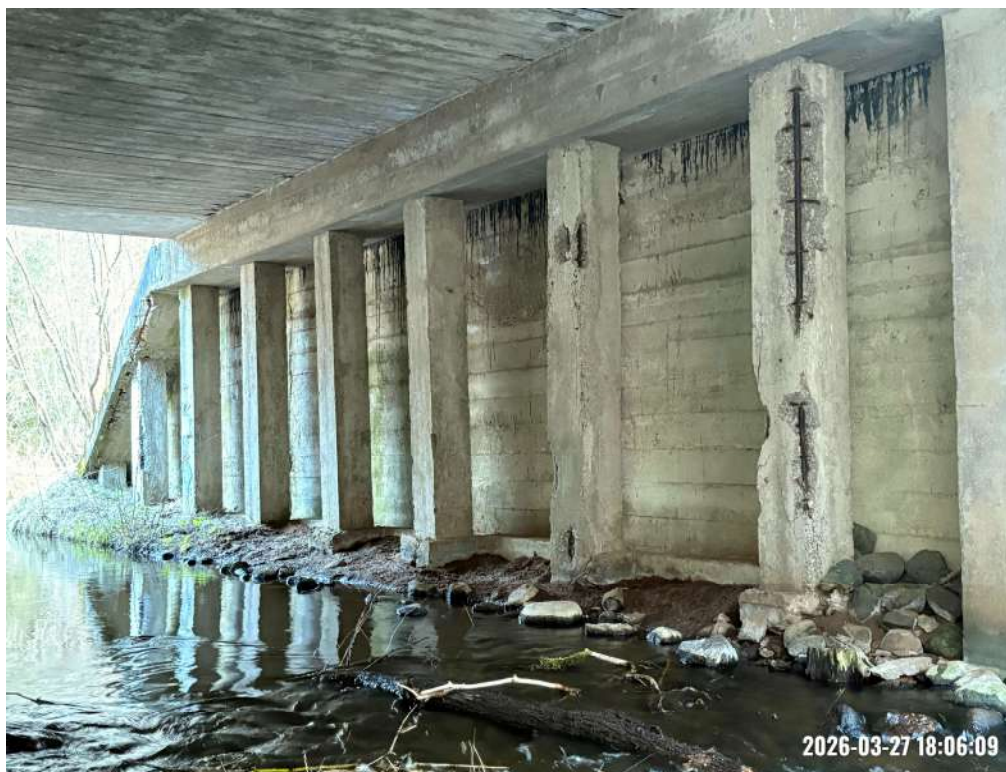
8 pav. Atšokęs apsauginis betono sluoksnis, korozijos paveikta armatūra.
