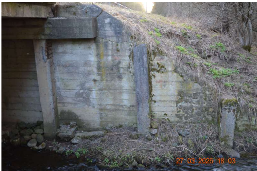
9 pav. Antros atraminės sienos sparno įtrūkimas
